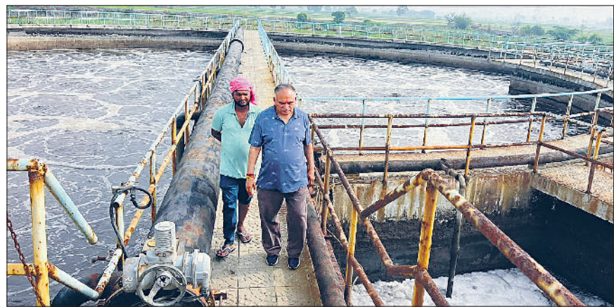
सोनीपत। ककरोई रोड स्थित सीवरज ट्रीटमेंट प्लांट का निरीक्षण कर व्यवस्थाओं का जायजा लेते मेयर राजीव जैन।
